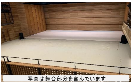
写真はステージに音響反射板を設置した状態です
